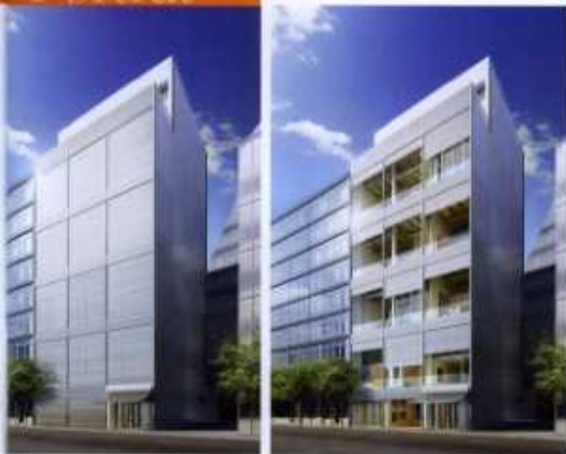
Inszeniert das „Metal Shutter House“, ein Apartmenthaus in New York mit perforierten Metalljalousien.
