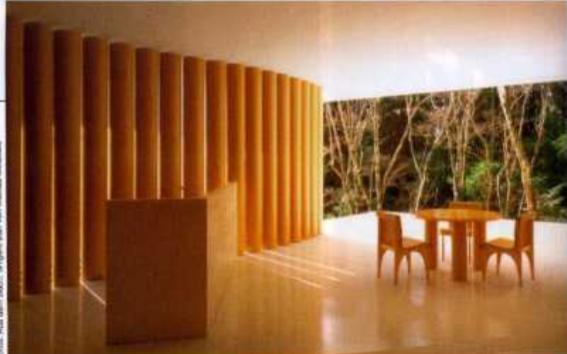
Klare Formen und außergewöhnliche Strukturen auch in Bans Wohnbauprojekten: Für das „Paper House“ (links) kamen 80 recycelte Pappröhren zum Einsatz. Das „Curtain Wall House“ (rechts) besticht durch seine formvollendete Eleganz
