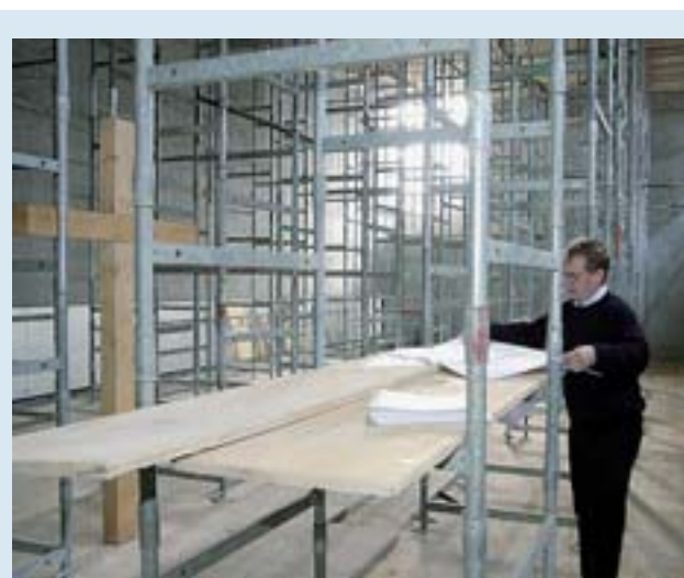
Illustrazione Siegfried Delueg nel cantiere della chiesa
