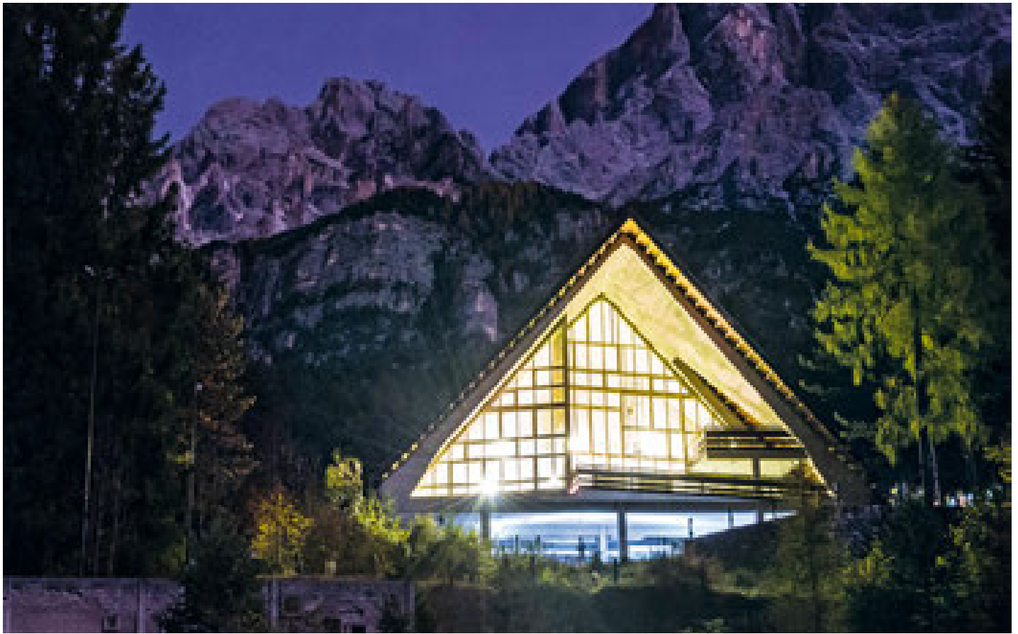
Aula Magna alla Colonia Ex Villaggio Eni e Monte Antelao
