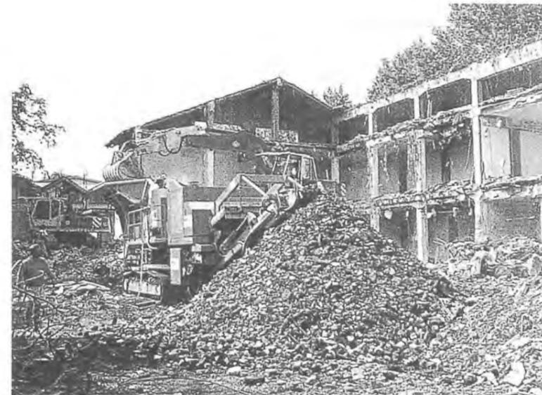
*Uso del frantoio mobile per il riciclaggio di materiale di demolizione*
