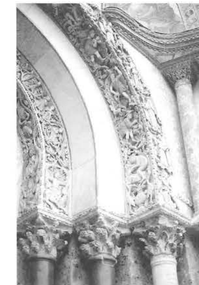
Dettaglio del portale centrale della basilica di S. Marco a Venezia dopo del restauro
