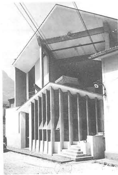
Stazione a valle funivia del Virgolo, Bolzano; vista dalla strada (1955).
