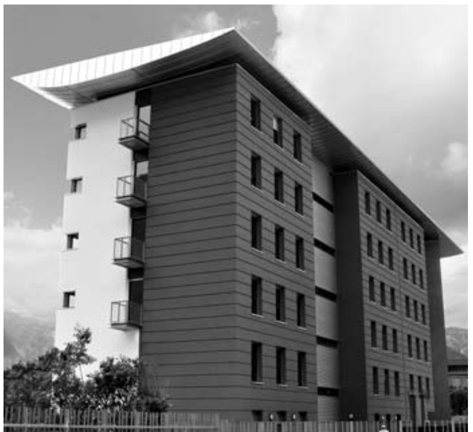
Antonio Lescio, Stefano Brida Gebäude mit 28 Wohneinheiten für das WOBI, Bozen / Edificio di 28 alloggi per l'IPES, Bolzano
