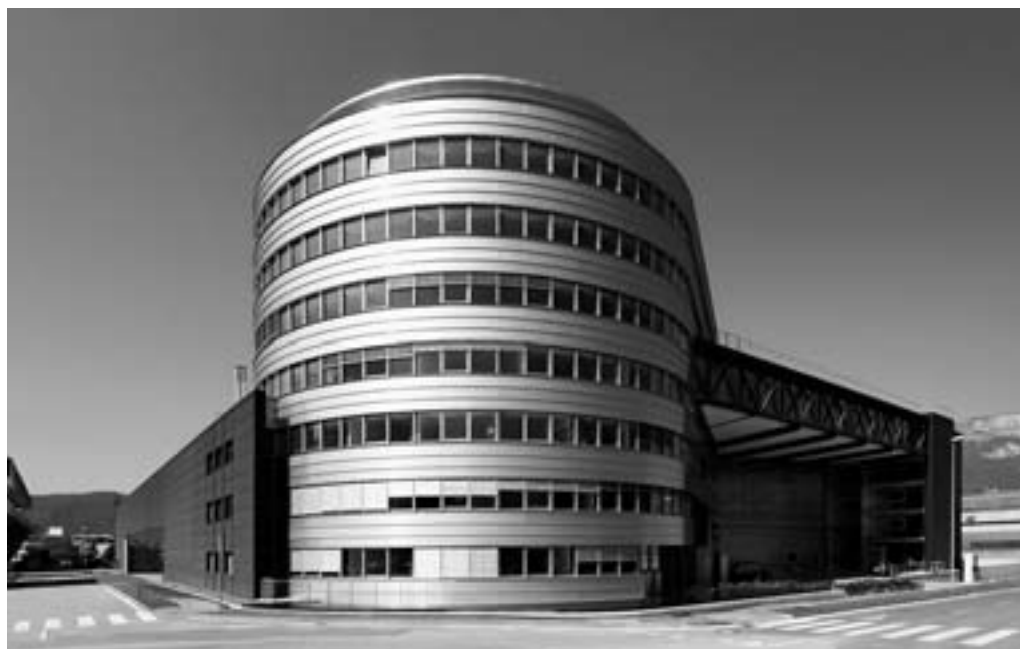
Walter Pichler & Partner Neuer Hauptsitz Stahlbau Pichler, Bozen / Nuova sede Stahlbau Pichler, Bolzano
