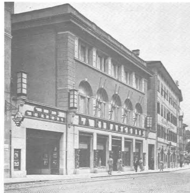
La Rinascente mit Eingang zum Kino - Bozen
