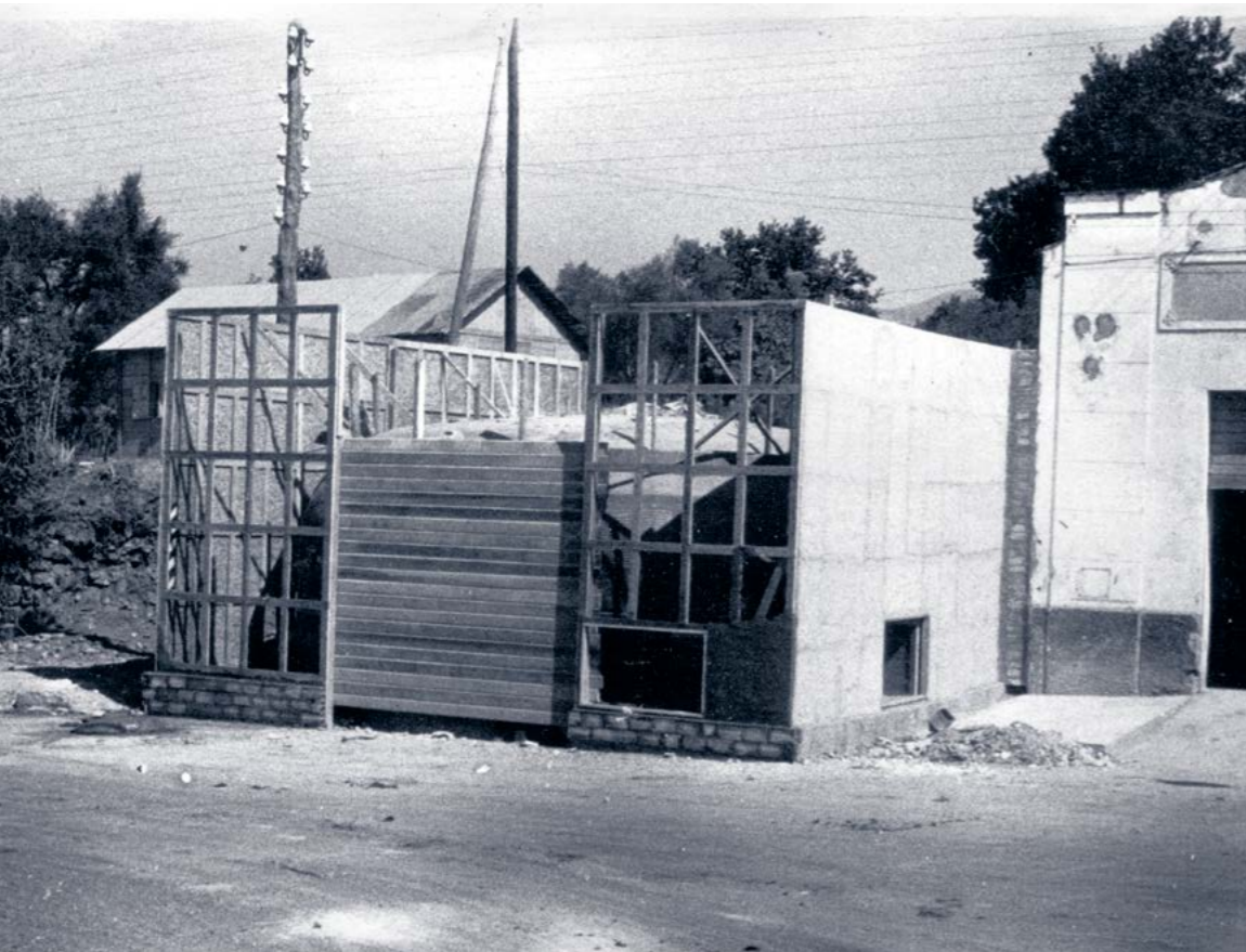
Im Bau befindliche kulissenartige Tarnung Finta facciata in corso di costruzione
