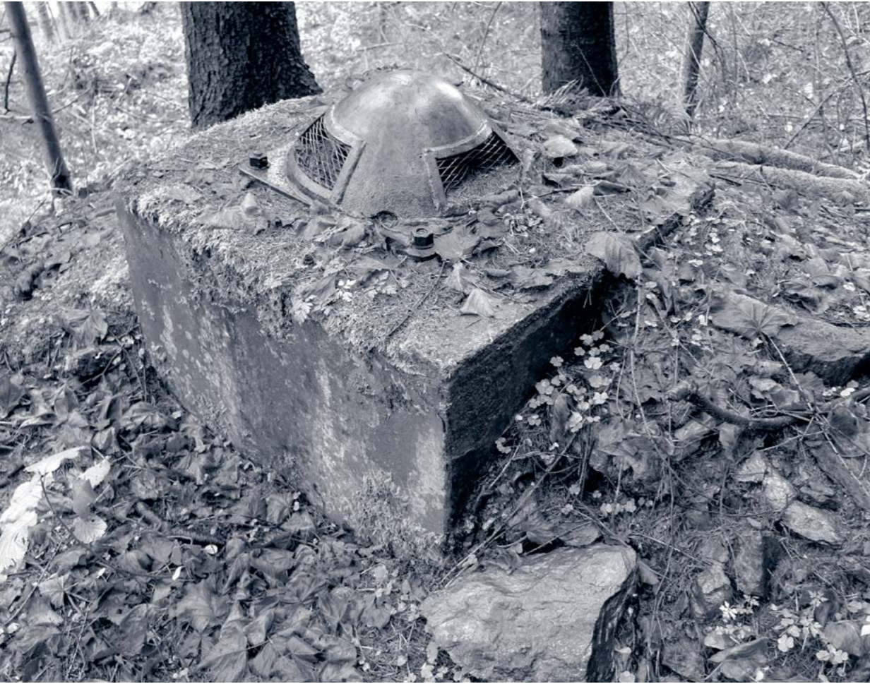
Gußeiserne Schutzkappe für Belüftungsöffnungen Calotta di protezione in acciaio fuso per la presa d'aria
