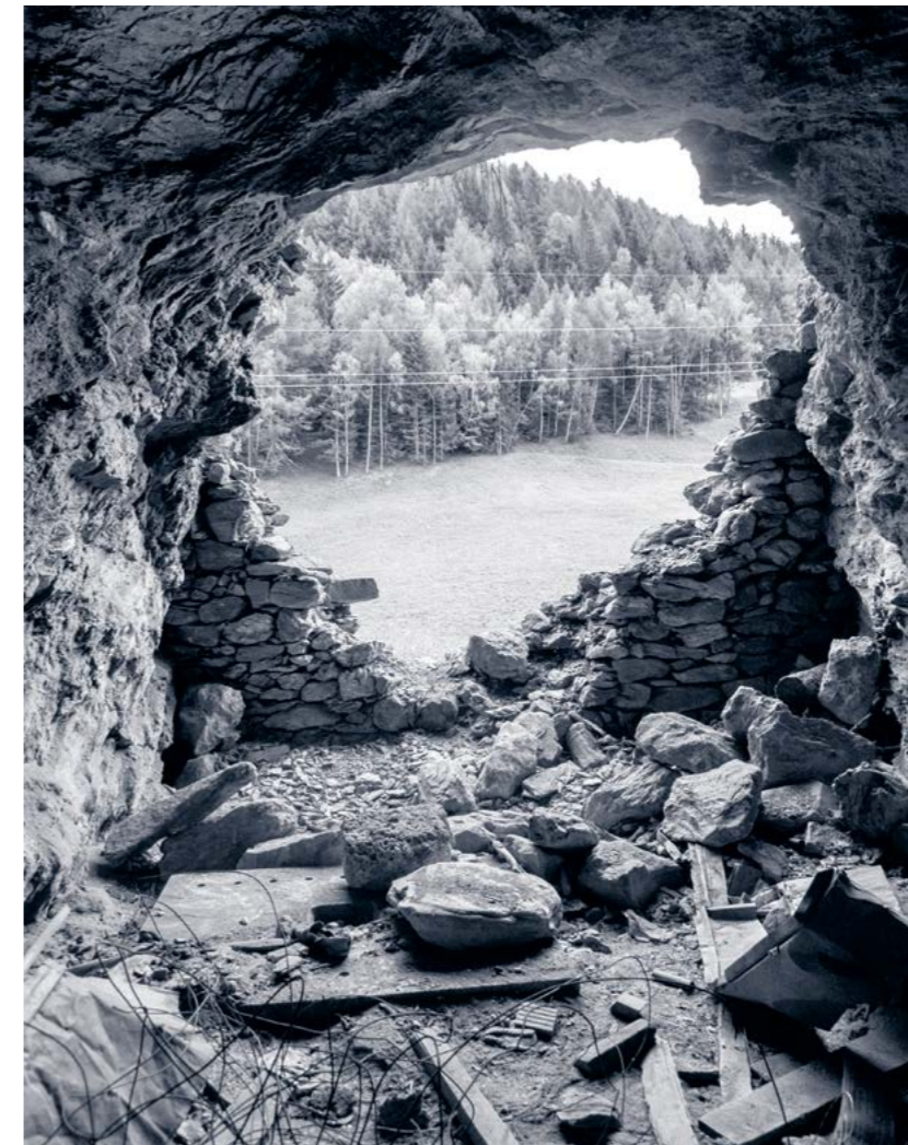
Eingestellte Baustelle – im Vordergrund liegt immer noch die tonnenschwere Panzerplatte zum Einbau in eine Schießscharte bereit
