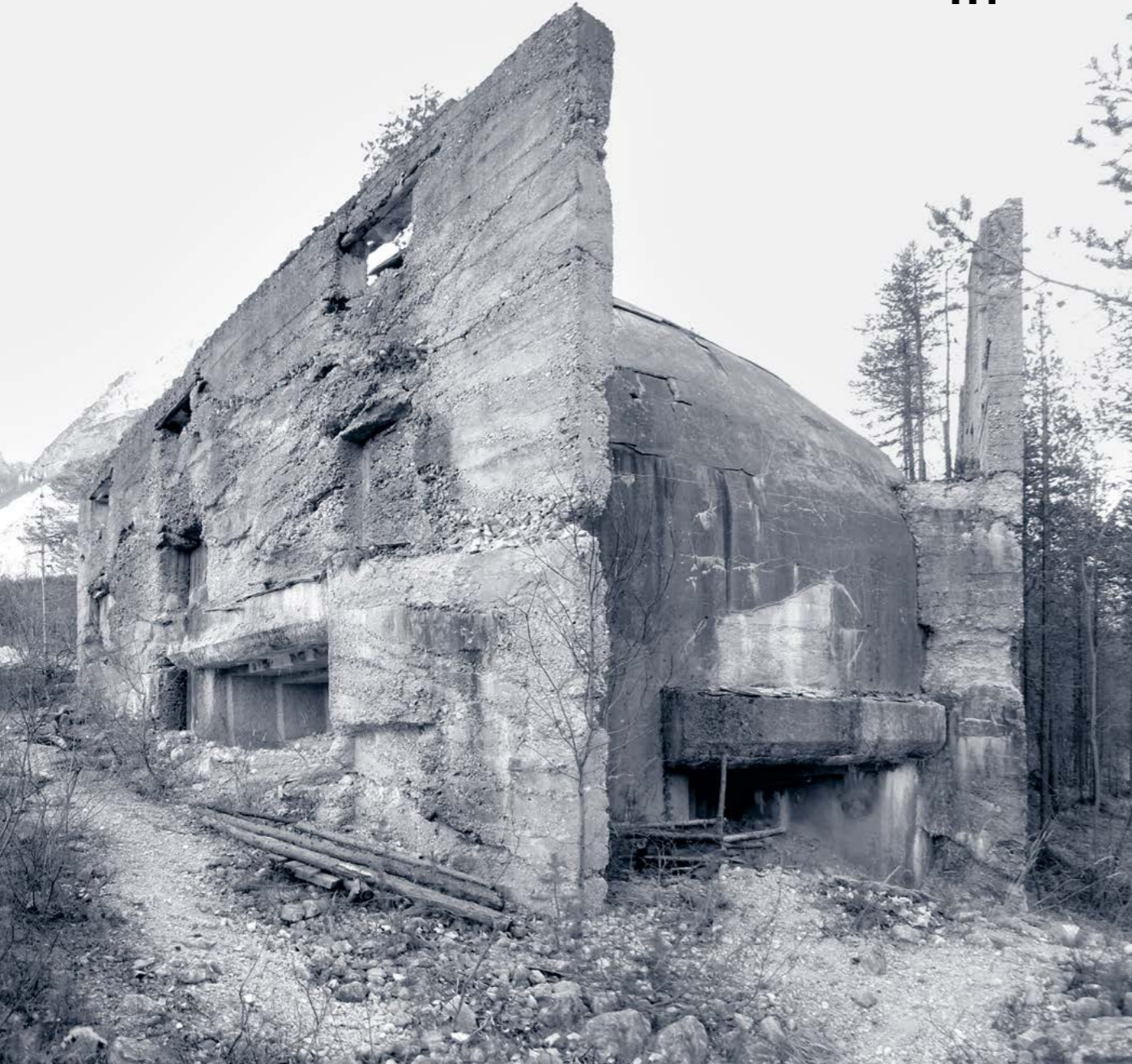
Vorgesetzte Tarnfassade Finta facciata anteposta all'opera
