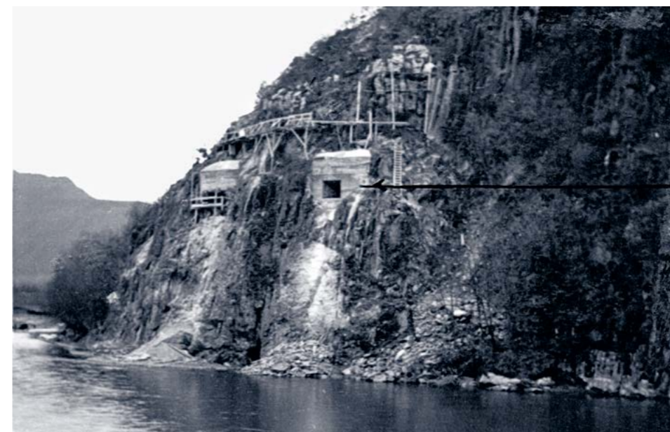
Werk Nr.19 der Sperre Bozen im Bau
