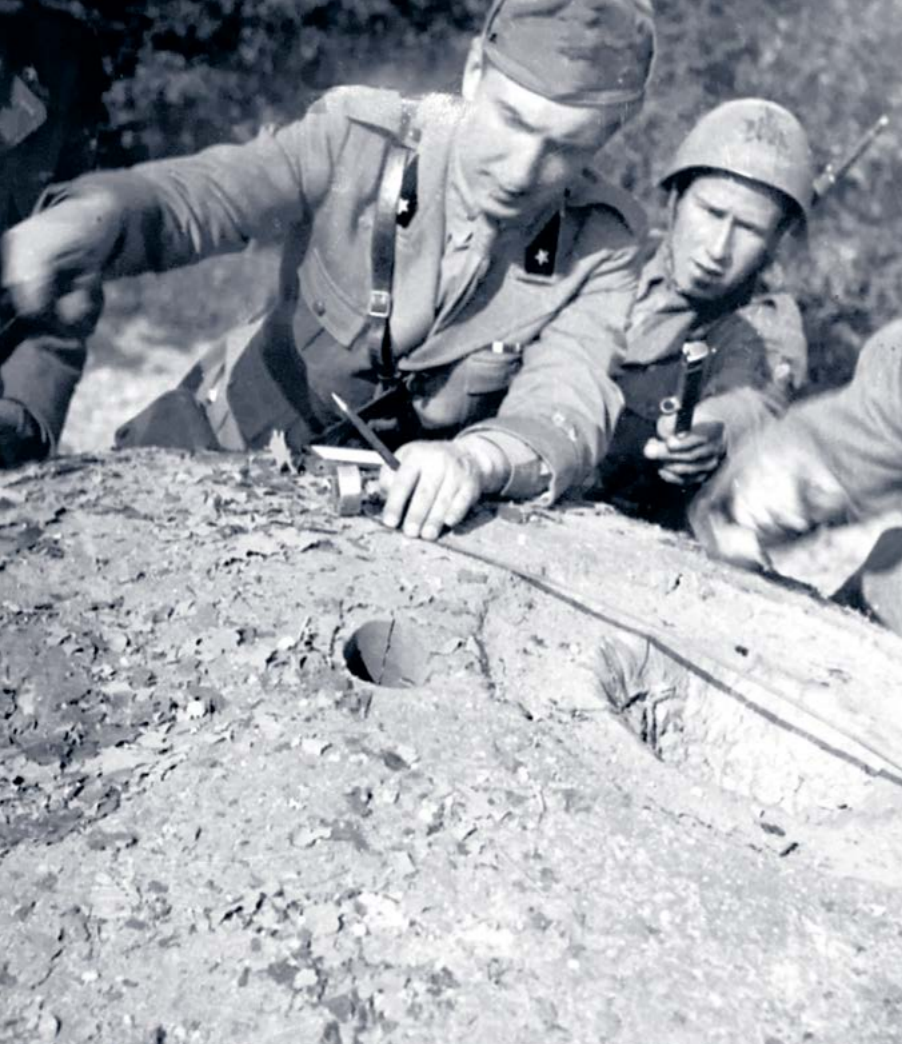
Fotodokumentation von Sprengversuchen an gepanzerten Stahlkuppeln Documentazione fotografica di prove di scoppio su cupole corazzate in acciaio
