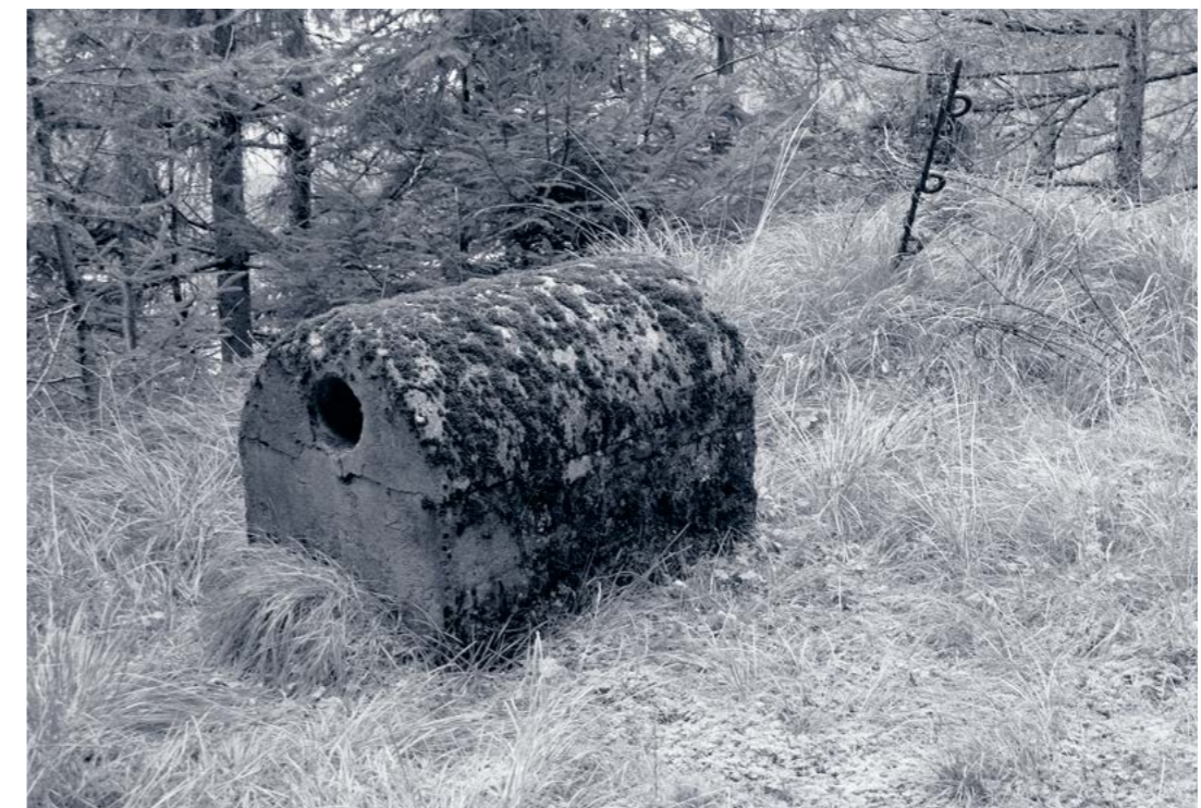
Betonierte Belüftungsöffnung Presa d'aria in calcestruzzo
