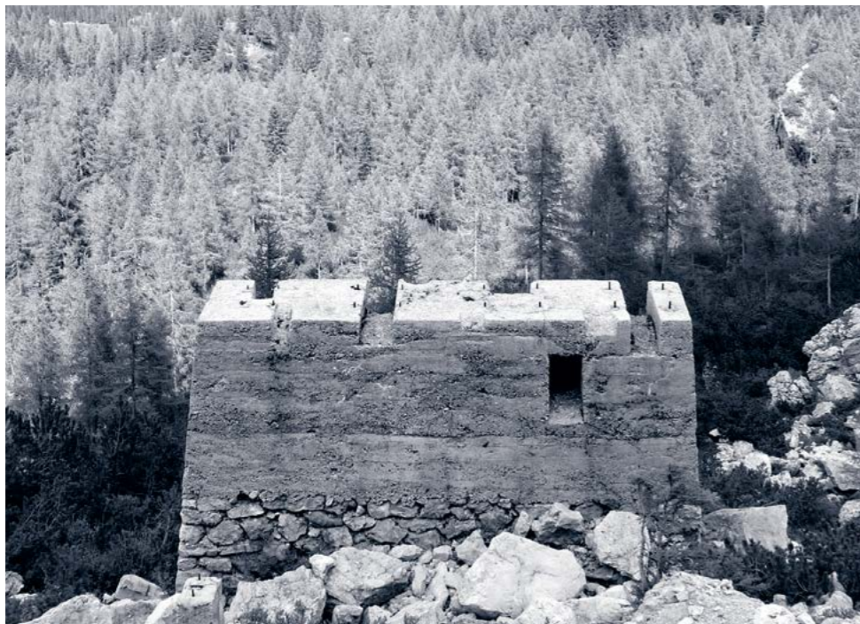
Le fondamenta di una teleferica sul passo di Monte Croce di Comelico
