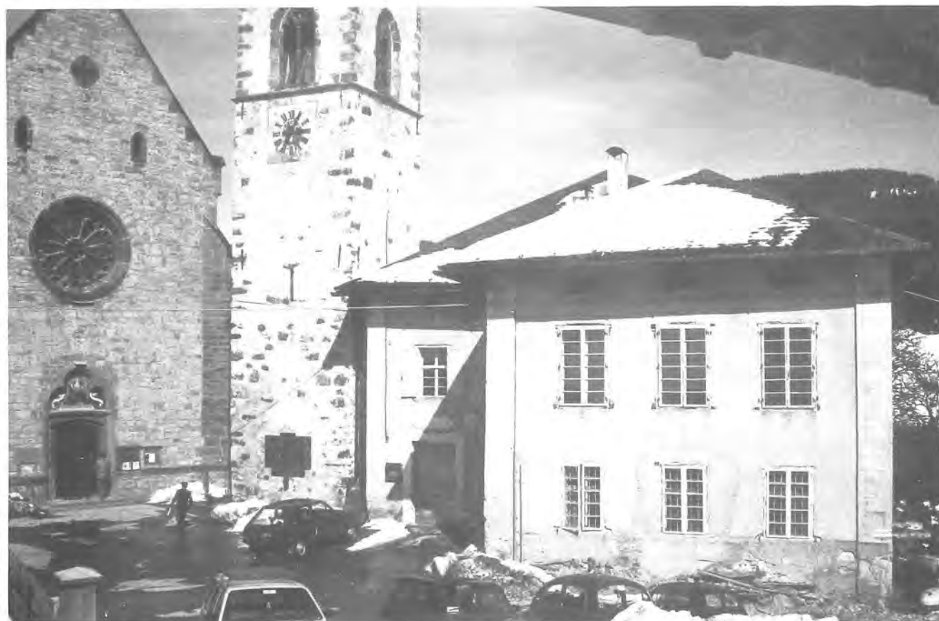
Situazione precedente all'intervento
