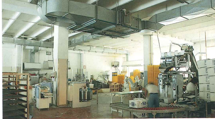
Capannone industriale Koch Bolzano/Industriehalle Koch Bozen
