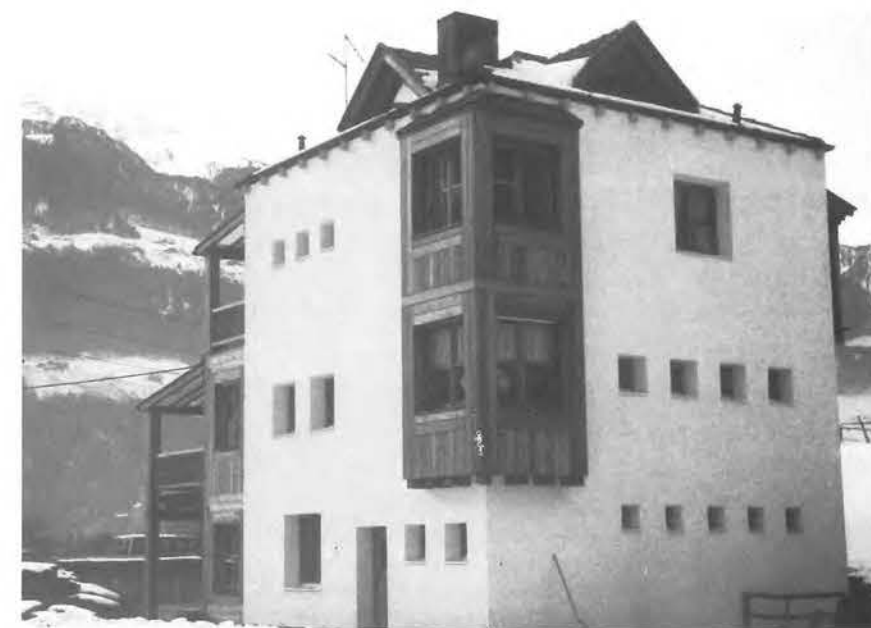
Haus eines Tischlers in Naturns/Casa per un falegname, (S. Valtingoier - J. Gritsch) Foto O. Seehauser
