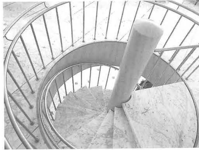
Detail Wendeltreppe die zur Galerieebene führt
