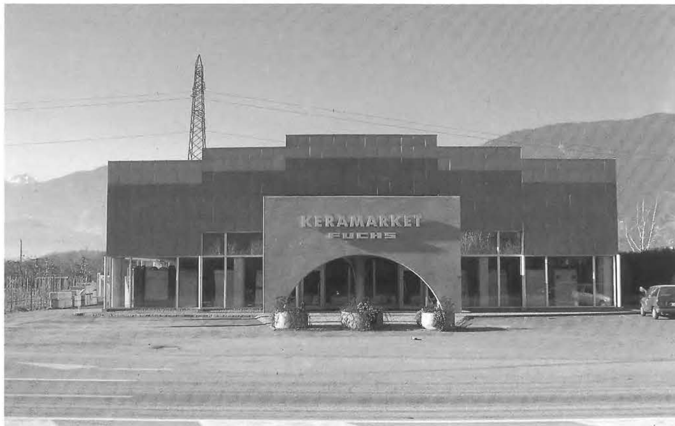
Hauptansicht nach erfolgten Umbau
