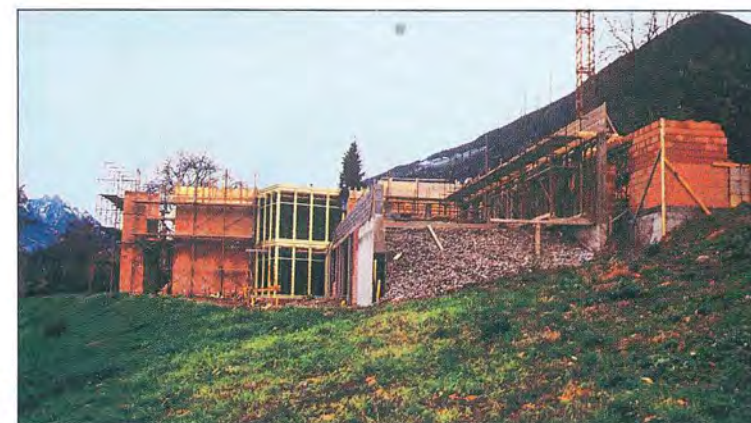
Baumeisterarbeiten Esecuzione opere edili
