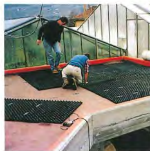
Fase di posa in opera del feltro di accumulo e degli elementi drenanti che precede quella del telo filtrante e dello specifico terriccio per giardino pensile.
