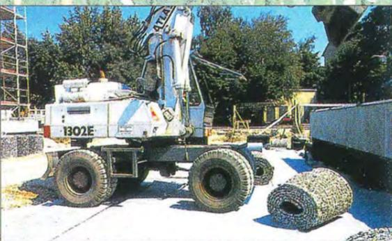
**DROPTEC** POSA FACILE E VELOCE DIRETTAMENTE SULLE SUPERFICI IMPERMEABILIZZATE. NOTEVOLE RISPARMIO DEI COSTI DI REINTERRO, IN QUANTO PERMETTE IL TRANSITO DI AUTOMEZZI PESANTI.
