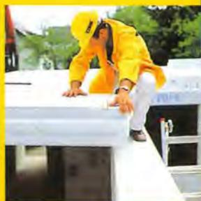
Verlegung des selbsttragenden bewehrten Platte für Decken und Dächer.
