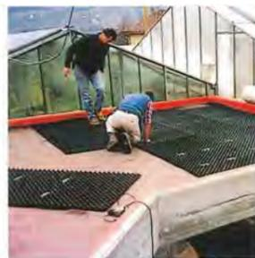
Verlegung des SPEICHERSCHUTZFILZES und der Drainageelemente, die der Verlegung der Filterplane und der eigens dafür vorgesehenen Erde für Dachgärten, vorgeht.
