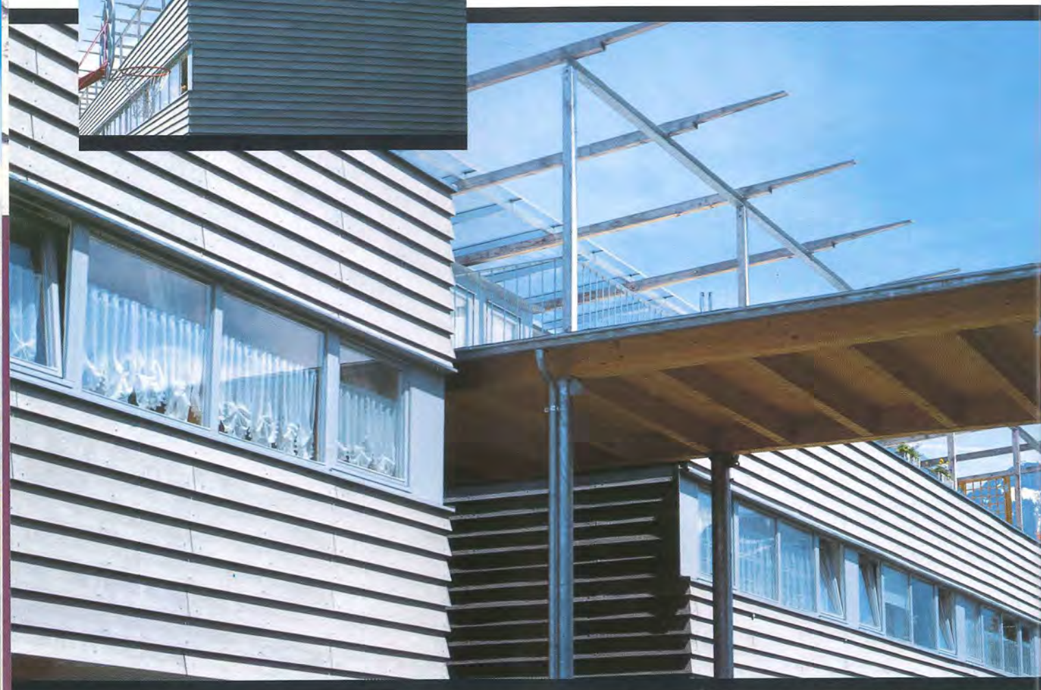
Reihenhäuser in Nofels/Vlb. Architekt: Baumschlager & Eberle, Lochau/Vlb. Verwendetes Material Stulpschalung in Baueternit 8 mm.
