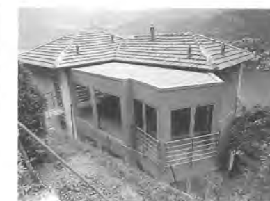
Ampliamento e ristrutturazione Villa Antonietta, Moltrasio (Como) 1997-98 Ampliamento in acciaio e vetro. Pavimento in resina-cemento.
