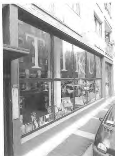
Centro Multimediale Libreria Tikun, Via Montevideo 9, Milano 1998 Serramenti esterni profili Jansen in acciaio. Scritta vetro sabbato.
