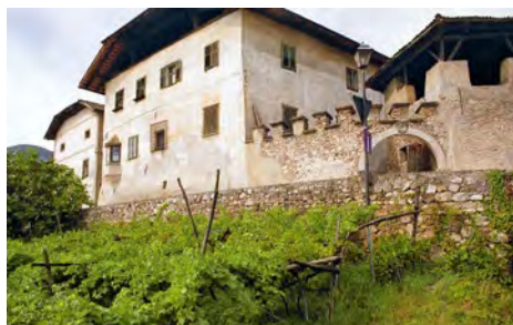
Una dimora fortificata a Cortaccia. Uno dei riferimenti utilizzati nel Manuale al Piano di attuazione del 09/2003.
